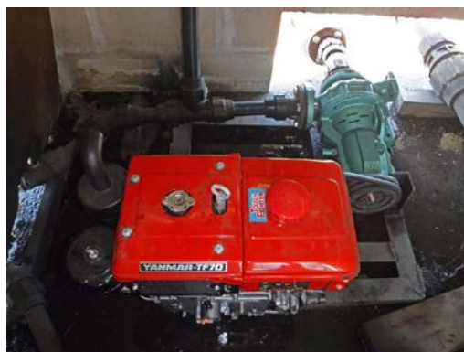
【海水取水ポンプ/エンジン据付け】
