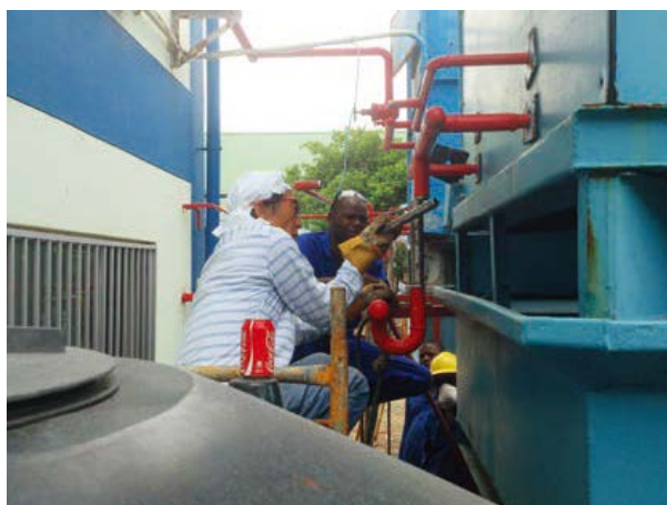
【専門家による製氷機の配管修理の技術指導】
