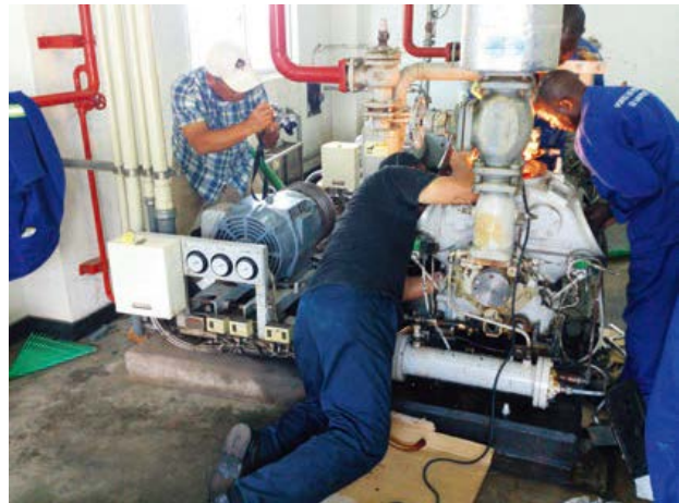
【専門家による冷凍庫コンプレッサー整備の技術指導】
