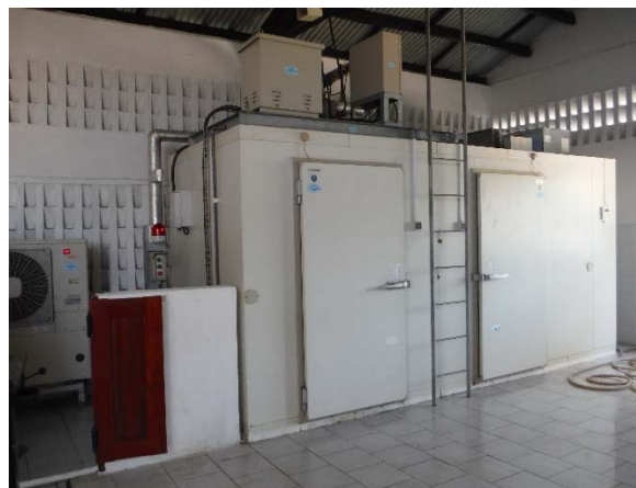
〔改修された製氷室内〕
