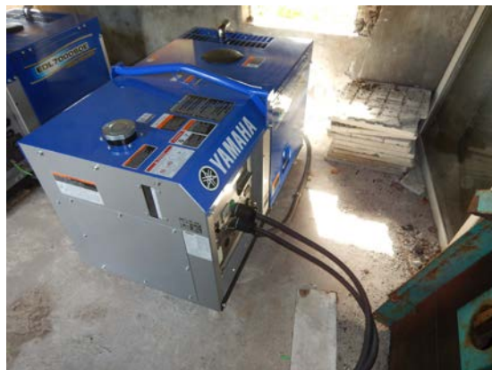
【ディーゼル発電機の設置】
