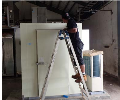
〔レル製氷施設：製氷機の設置〕
