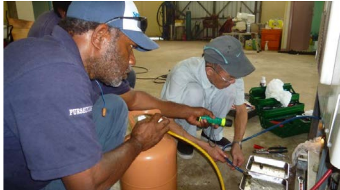
【NFC 製氷施設：カウンターパートへの冷媒ガスの充填方法指導】
