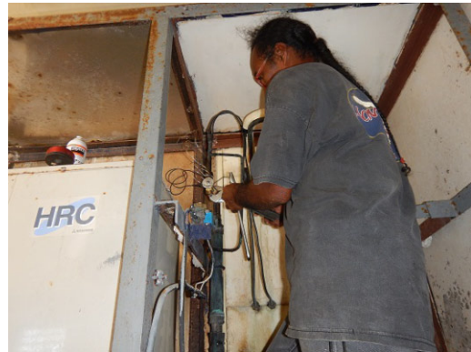
【ペリリュー製氷施設：自動膨張弁交換】
