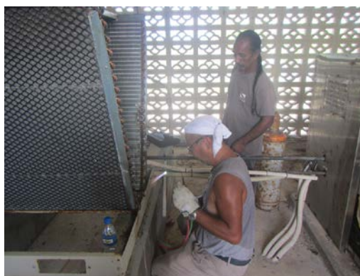
【アルコロン州製氷施設：コンデンサー漏えい箇所修理】
