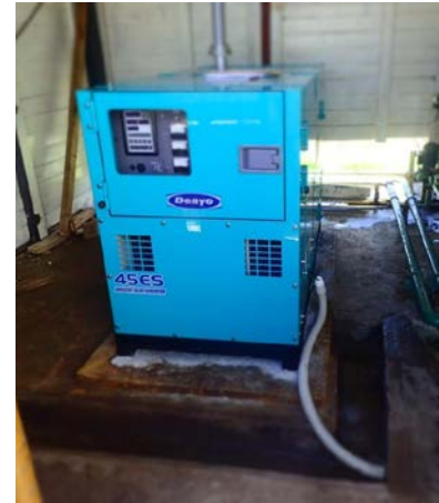
〔ブニセア製氷施設：発電機の設置〕
