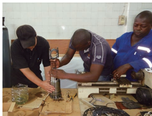
冷凍機コンプレッサーのシリンダー取付
