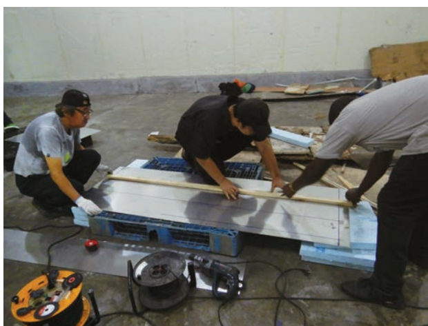
冷凍1号室の扉改修
