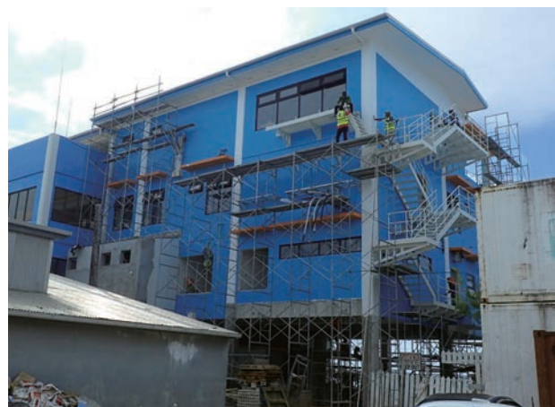
完成間近のMIMRA別館 2024年5月2日撮影
