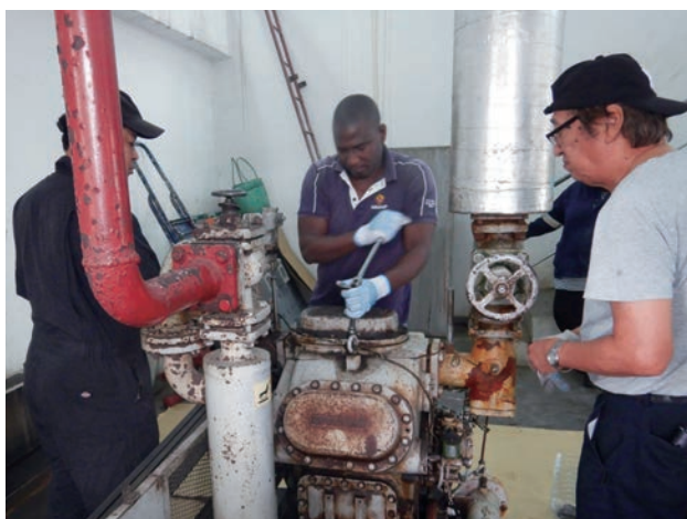
製氷機コンプレッサーのオーバーホール指導
