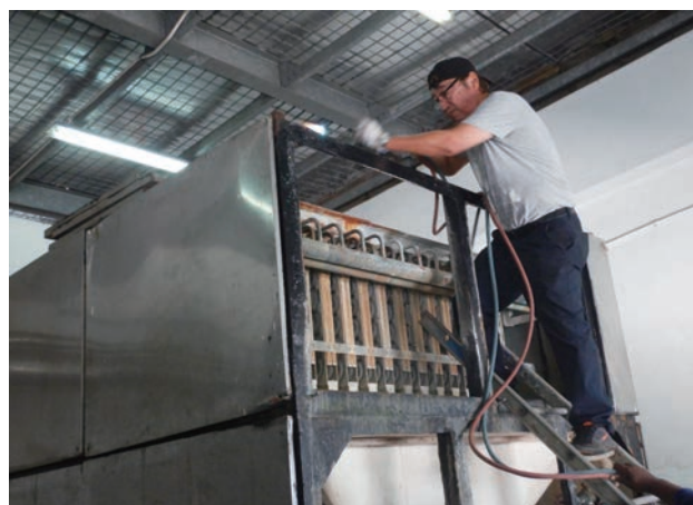
製氷機配管周りの溶接作業
