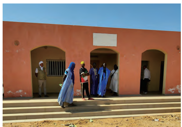
ウンブツ水産センター敷地内の市場（外観）
