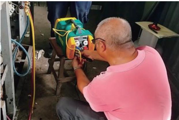
オゾン層破壊係数が高いR22冷媒の回収作業
