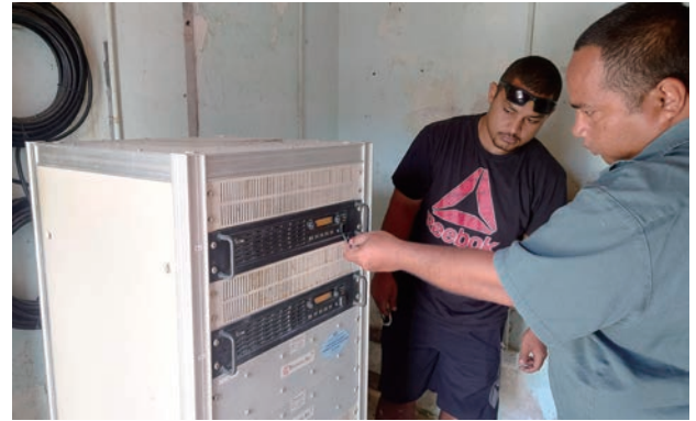
ラジオリピーターシステムの修理
