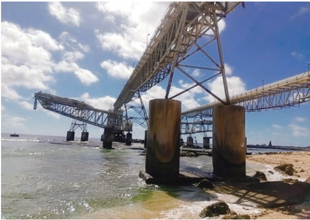
リン鉱石を船に運ぶためのカンチレバー
